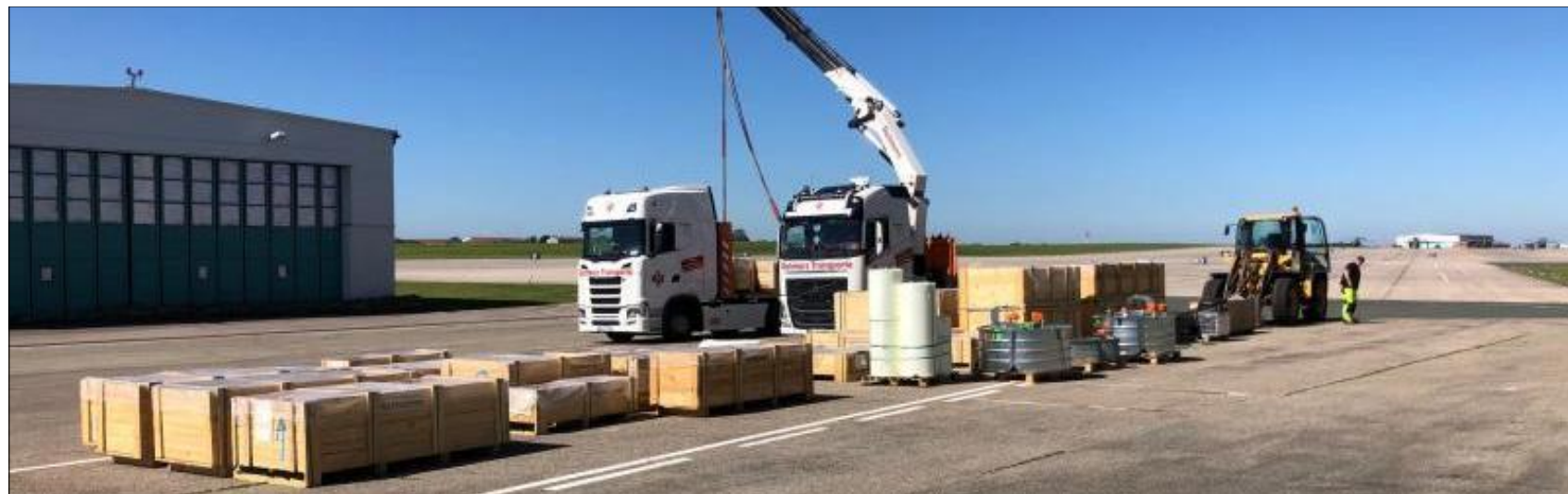
Die Inliner für die Rohr-in-Rohr-Sanierung wurden direkt auf dem Flugfeld abgeladen und vor Ort verbaut.
