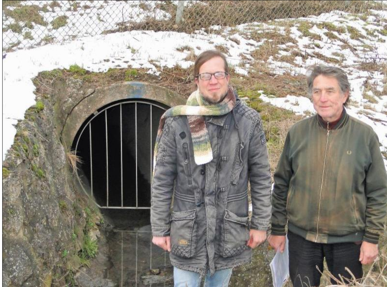
Boris-André Meyer und Wolfgang Schmidt (von links) von „Etz langt's“ an einem der Einlässe des Regenwasserkanals zum Milmersbach, südlich der Kaserne Katterbach. Foto: Winfried Vennemann
